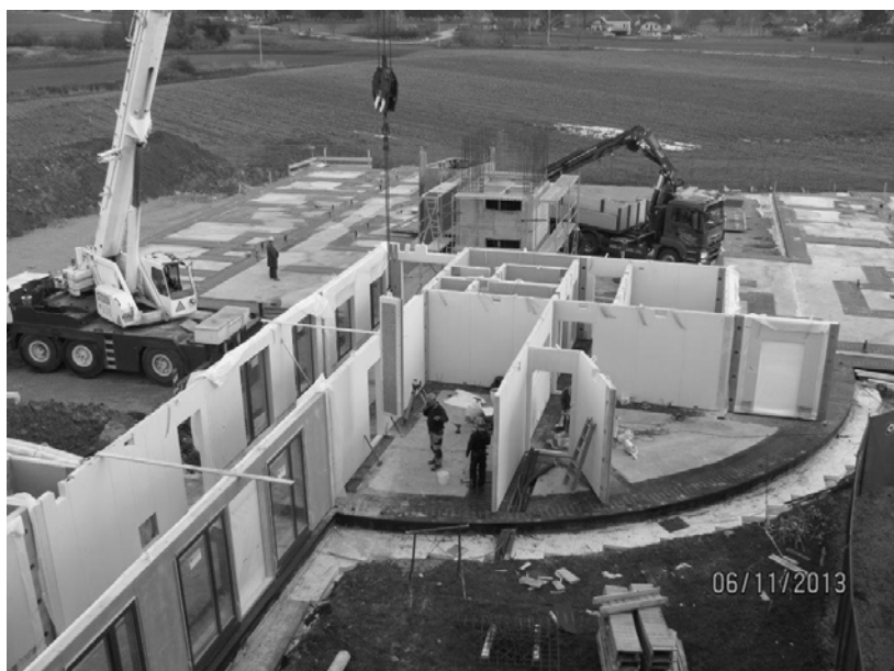
Slika 5: Objekt je montažne izvedbe z lahko konstrukcijo
