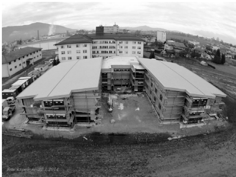
Slika 4: Posnetek gradnje Enote za stanovalce z demenco
